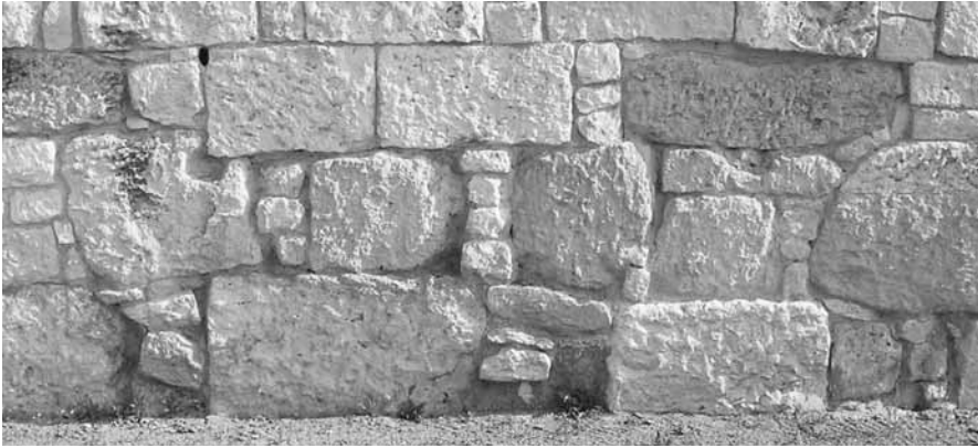
Εικ. 2. Νότια στοά. Δείγμα τοιχοδομίας.
