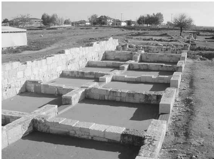
Εικ. 1. Νότια στοά. Χώροι I-X μετά τη συντήρηση.
