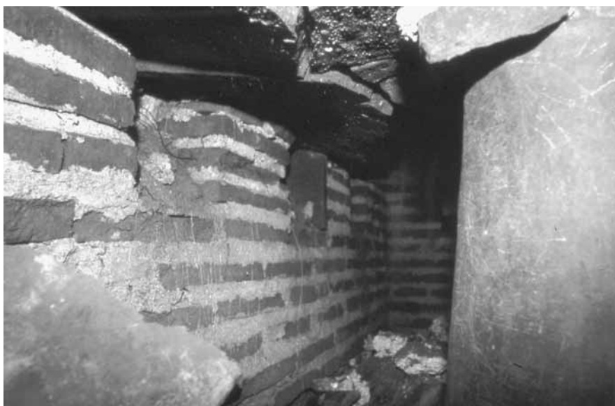
Εικ. 15. Νησίδα καταστημάτων-εργαστηρίων. Υπόκαυστο του ΝΔ δωματίου της αρχαιότερης οικίας.
