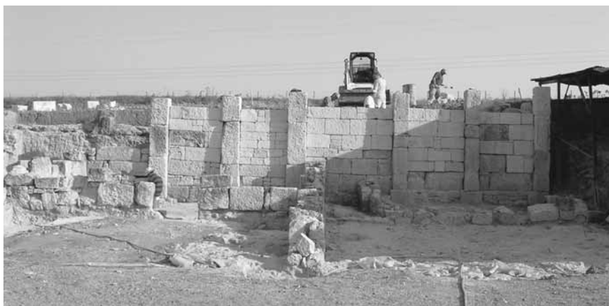
Εικ. 25. Τμήμα αναλημματικού τοίχου.
