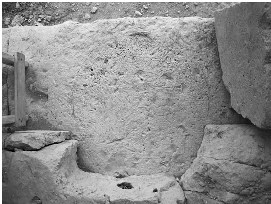
Εικ. 23. Κλίμακα ΒΑ γωνίας με διαμορφωμένο αναβαθμό για να δεχθεί κίονα.
