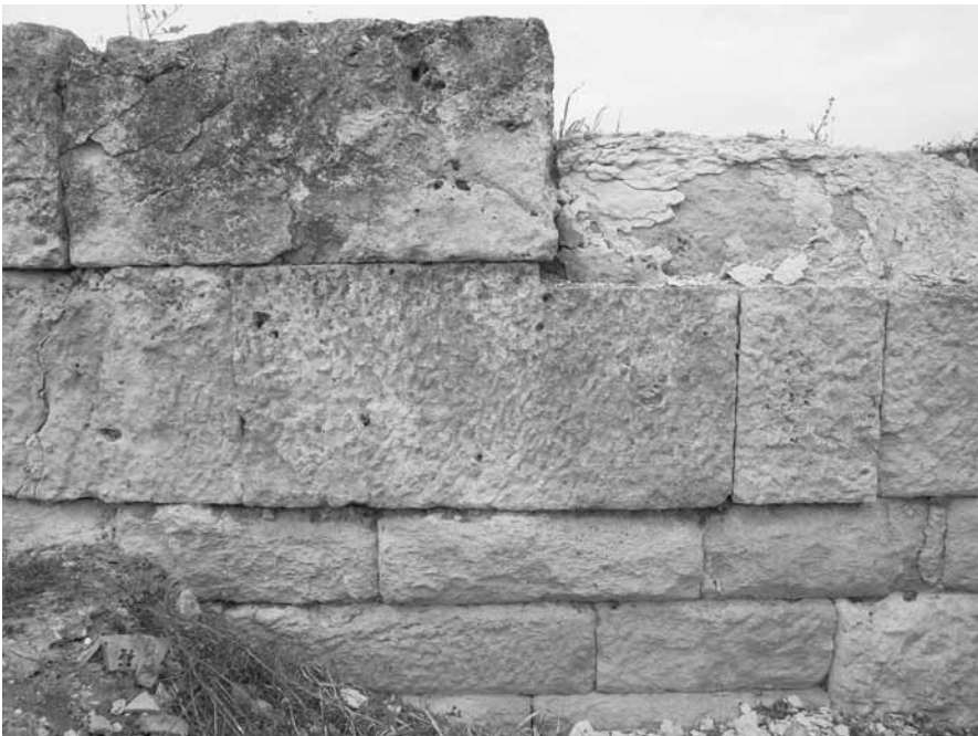
Εικ. 3. Νότια στοά. Δείγμα τοιχοδομίας.
