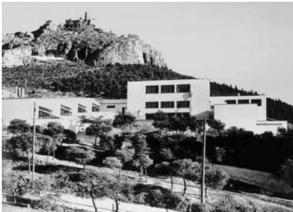
Εικ. 4. Δ. Πικιώνης, Δημοτικό Σχολείο στα Πευκάκια , Αθήνα 1931-32 (προέλευση εικόνας: Π. Καραντινός, Τα Νέα Σχολικά Κτίρια , Αθήνα 1938).
