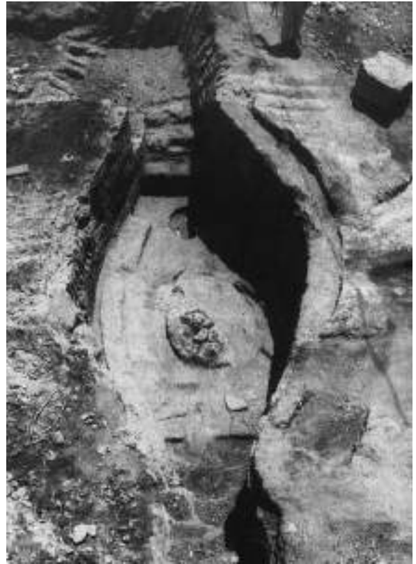
Εικ. 4. Ρόδος, οικόπεδο Μυλωνά. Μεγάλο όρυγμα χύτευσης κατά την αποκάλυψη.
