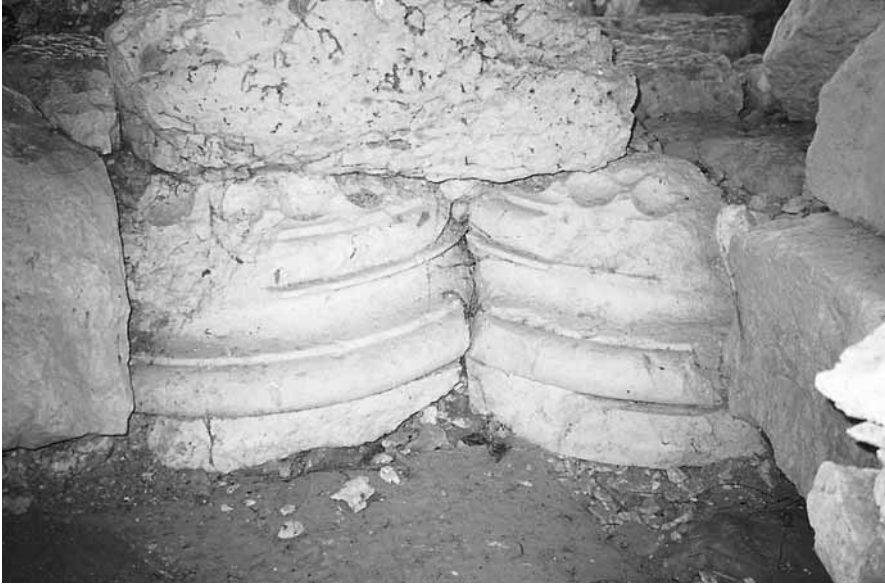
Abb. 23. Pella, Palast, in die obige Mauer verbaute Säulenbasen.
