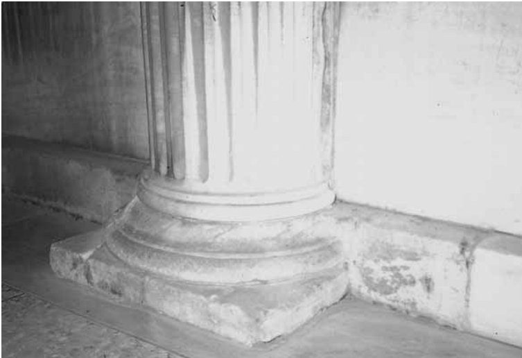
Abb. 44. Athen, Halle Attalos' II., Doppelsäulenpfeiler vom Obergeschoß.
